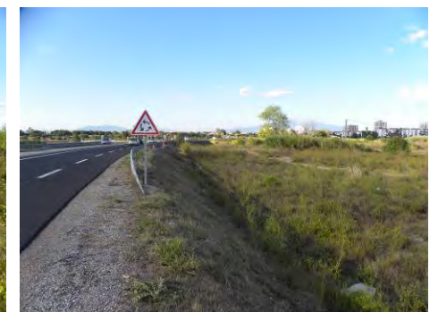
Remblai de la RD 22c
