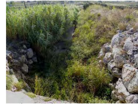
Ruisseau du Pou de les Colobres en aval de la RD 22c.
